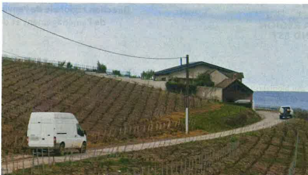
Vue de la maison existante depuis le chemin des Chauffours – Vue Google Maps
